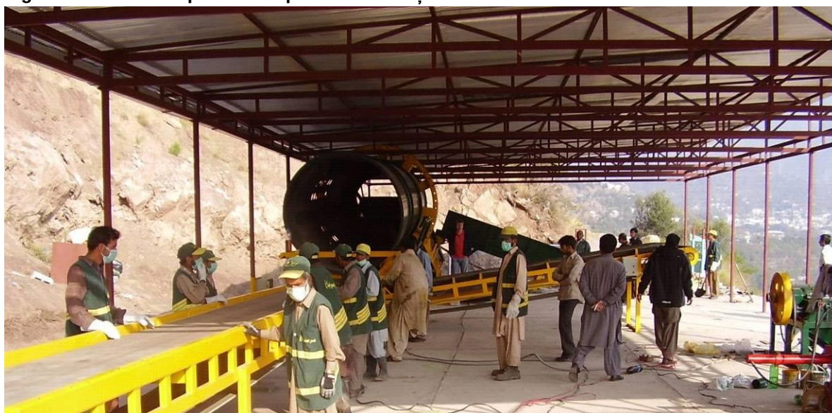
Figura 10-11: Exemplu de echipamente la stația de sortare
